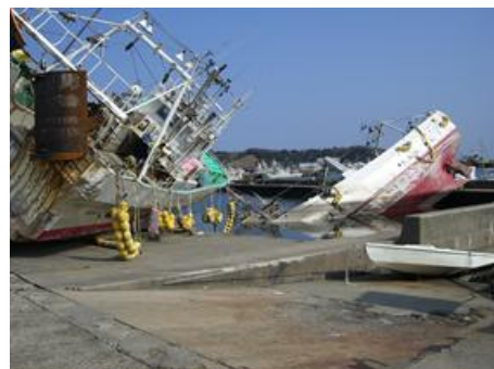
小名浜港：津波による漁船の被害
